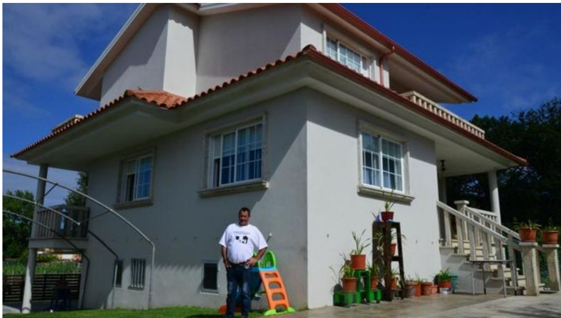
Ramón, en su casa, al que le llegó ya la segunda orden de derribo. | //
